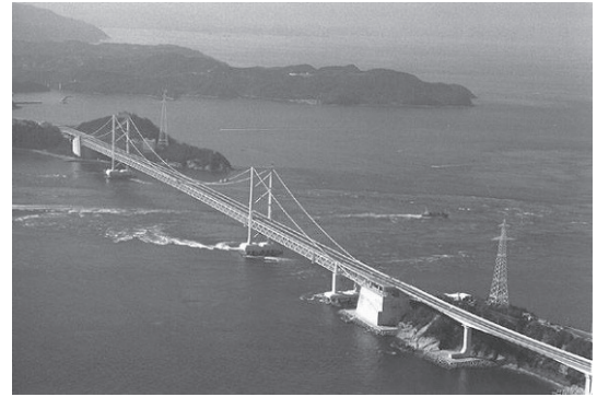
図2 淡路側から見た大鳴門橋と送電鉄塔 (徳島新聞社提供)
